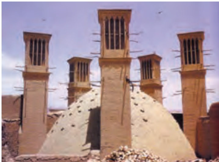
تصویر شماره ۲-۵۰- آب انبار و بادگیرهایش
