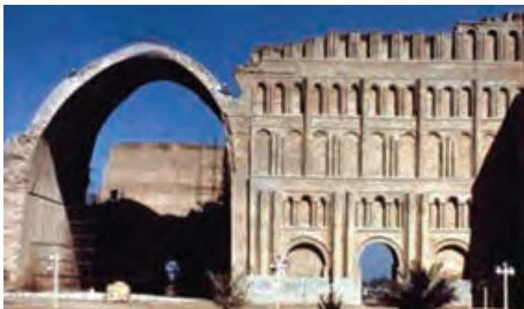
تصویر شماره ۲۸-۲- ایوان مدائن یا تاق کسری، نمونه بارز تاق آهنگ در دوران پیش از اسلام
