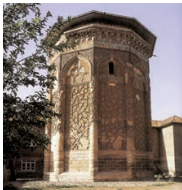
▲ شکل ۹-۵- گنبد کبود، مراغه، آذربایجان شرقی
