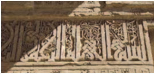
شکل ۶۲-۲- خراسان، آجر تراش، رباط شرف
