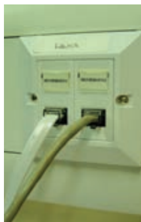
شکل ۲۶-۳- تصویر ظاهری و شمای فنی پریز تلفن
