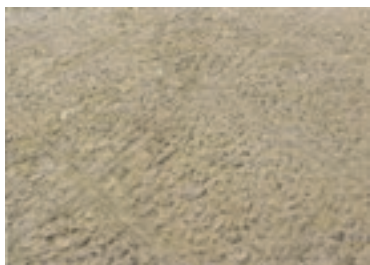
شکل ۲-۱۰۵- یزد، باغ دولت آباد، آژیانه
