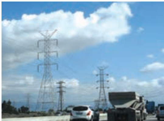
شکل ۵-۳- انتقال انرژی الکتریکی توسط دکل ها
