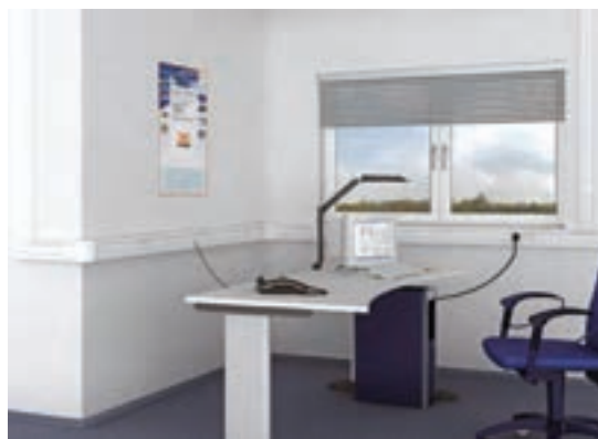
شکل ۳۲-۳- نمونه‌هایی از سیم کشی روکار
