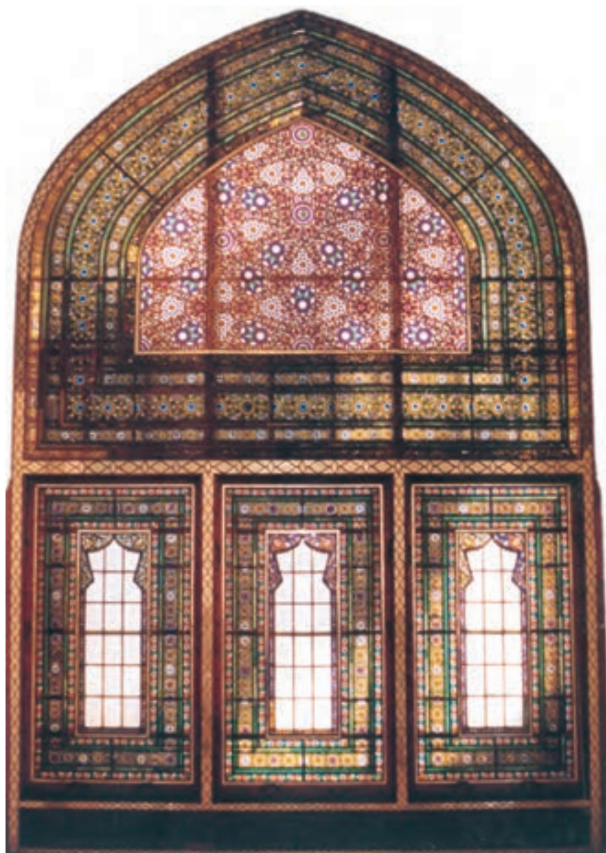
تصویر ۱۴-۲-۱- نمونه ای از گره چینی شیشه دار به همراه قواره بری و پارچه بری در روی یک پنجره ارسی صفوی
