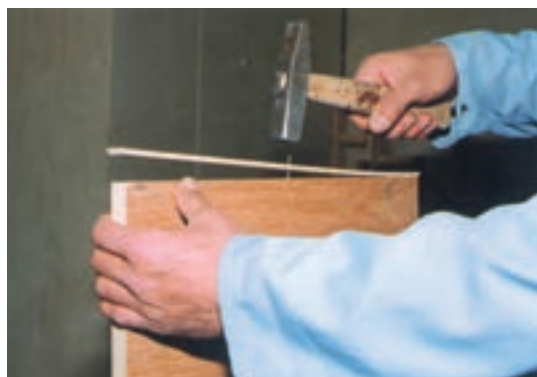
تصویر ۱۲-۶-۲- زهوارکوبی دور لبه زیرساخت
